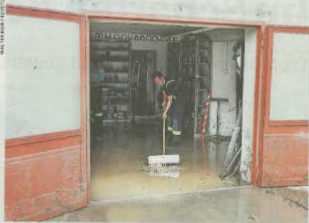
Grosse Schäden nach Unwetter in Uerkheim (AG). (9. Juli 2017)
